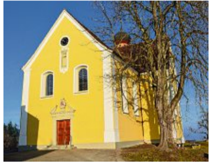
Die Fassade der Wallfahrtskirche Maria vom Berge Karmel in Baitenhausen glänzt wieder. BILD: KATHOLISCHES PFARRAMT
