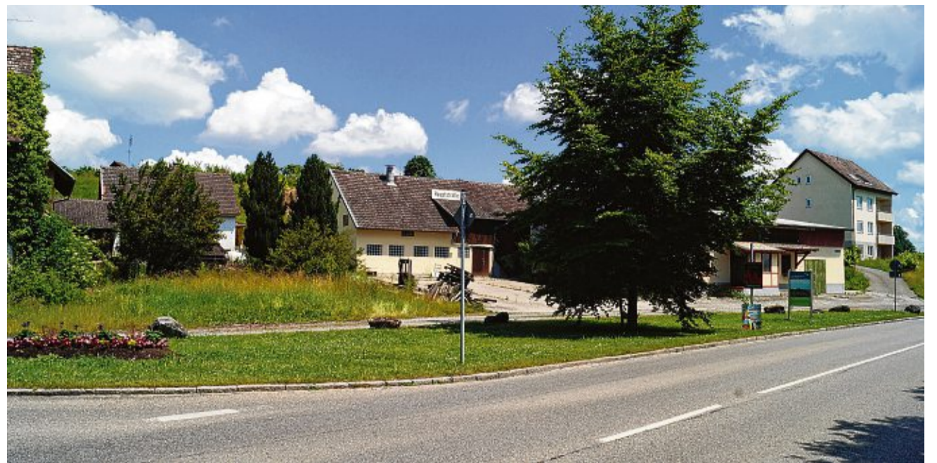
Auf dem Areal ab der Ausfahrt Riedetsweiler Straße in Stetten entlang der Hauptstraße/Bundesstraße 33 in Richtung Markdorf soll ein knapp 0,9 Hektar messendes Wohngebiet entstehen, in dem neben Doppel- und Mehrfamilienhäusern auch eine Seniorenwohnanlage geplant ist. Das Bild stammt vom Juni vergangenen Jahres. ARCHIVBILD: MARTINA WOLTERS
